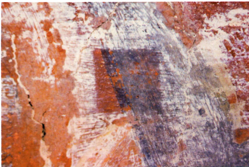
Il.7. Próba oczyszczania włóknem szklanym. Zdejmowanie pobiał z warstwy malarskiej.
